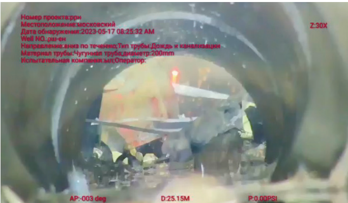
Обследование трубы с использованием мобильной системы PV.MH30
