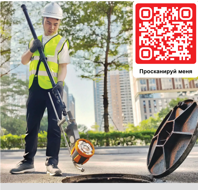
Мобильная система ПАЙП-ВЬЮ PV.MH30, подготовка к работе
